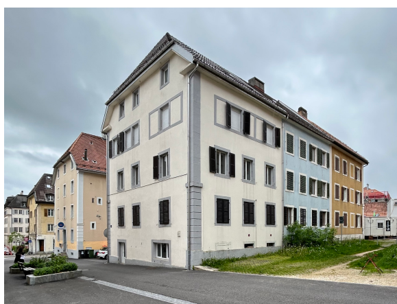
Immeuble vu de l'angles Nord-Est
